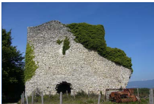
Ruines de la Tour Florimon à Charray
