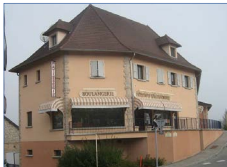
Construction récente avec toiture à forte pente brisée
