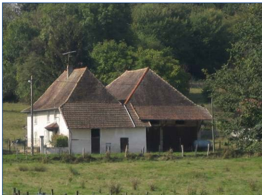
Maison dauphinoise avec toiture à forte pente brisée et à quatre pans
